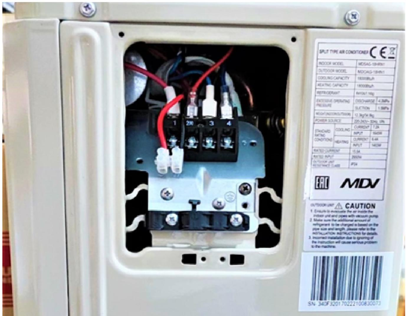
Для запуска кондиционера, необходимо произвести подключение питания на нештатную клеммную колодку, находящуюся рядом с основной, как на фото. На нештатную клеммную колодку необходимо подать отдельное питание 220В; питание желательно производить из места подключения самого кондиционера, соблюдая полярность проводного подключения, где Красный провод -Фаза, Черный провод -Нейтраль.
